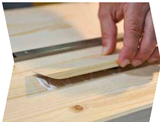
Leim los: An den Enden wird mehr aufgetragen, dann kommt der Flicker drauf
