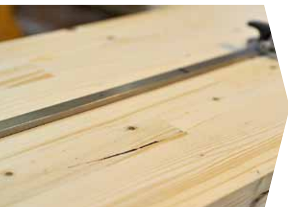
Der Riss muss weg: Zuerst wird dazu die Edelstahl-Führungsschiene angelegt
