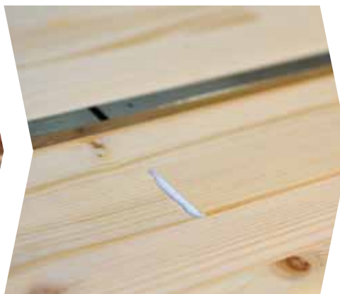
Fast fertig: Noch ein Schlag mit dem Gummihammer, dann ist der Flicker am rechten Fleck
